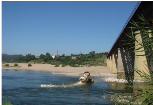
Figura 6. Construção de Plataforma de trabalho.
