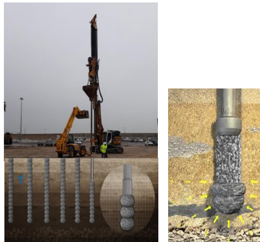
Figura 2. Representação gráfica do processo de execução das colunas de brita compactada.
