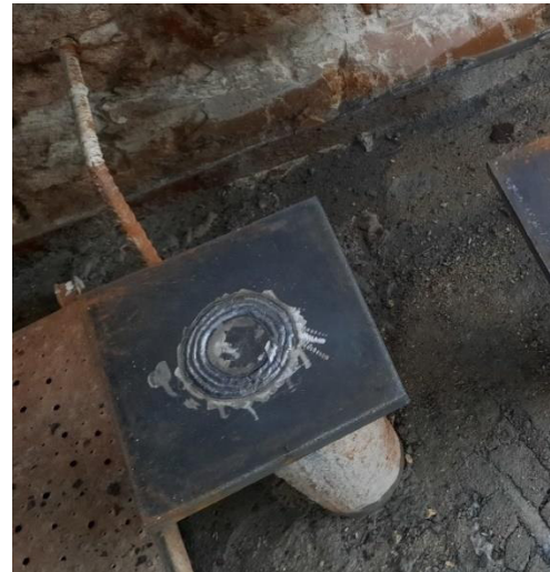
Figura 11. Chapa de Topo Microestacas.
