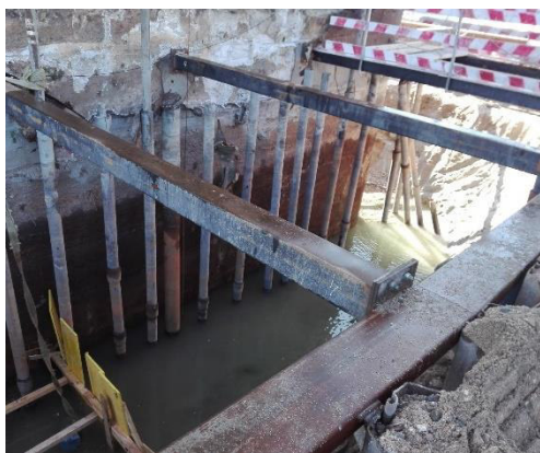
Figura 18. Vista dos travamentos da enseadeira.
