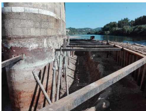
Figura 17. Vista do interior da enseadeira.
