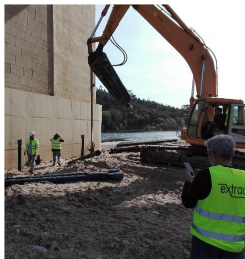
Figura 9. Execução de microestaca cravada junto ao Pilar P5.
