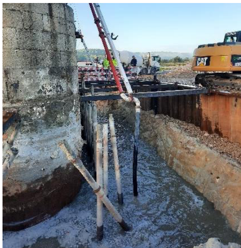
Figura 16. Betonagem do tampão de fundo.
