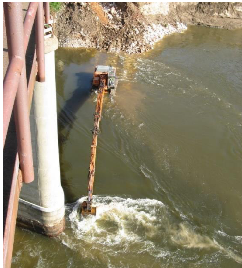
Figura 7. Trabalhos de reperfilamento do fundo da plataforma de trabalho.
