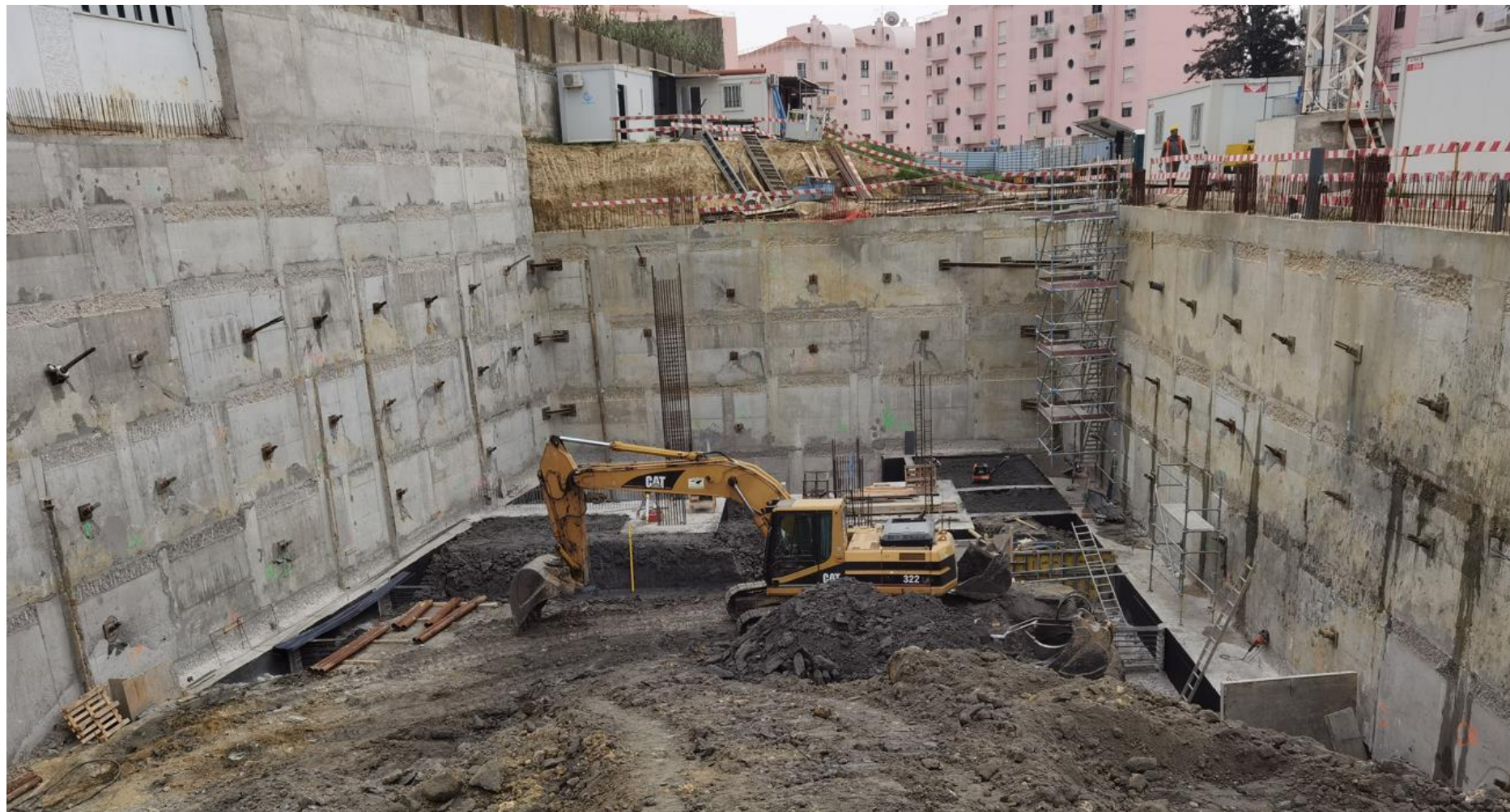
➤ Chegada ao Fundo de Escavação do Lote 2
