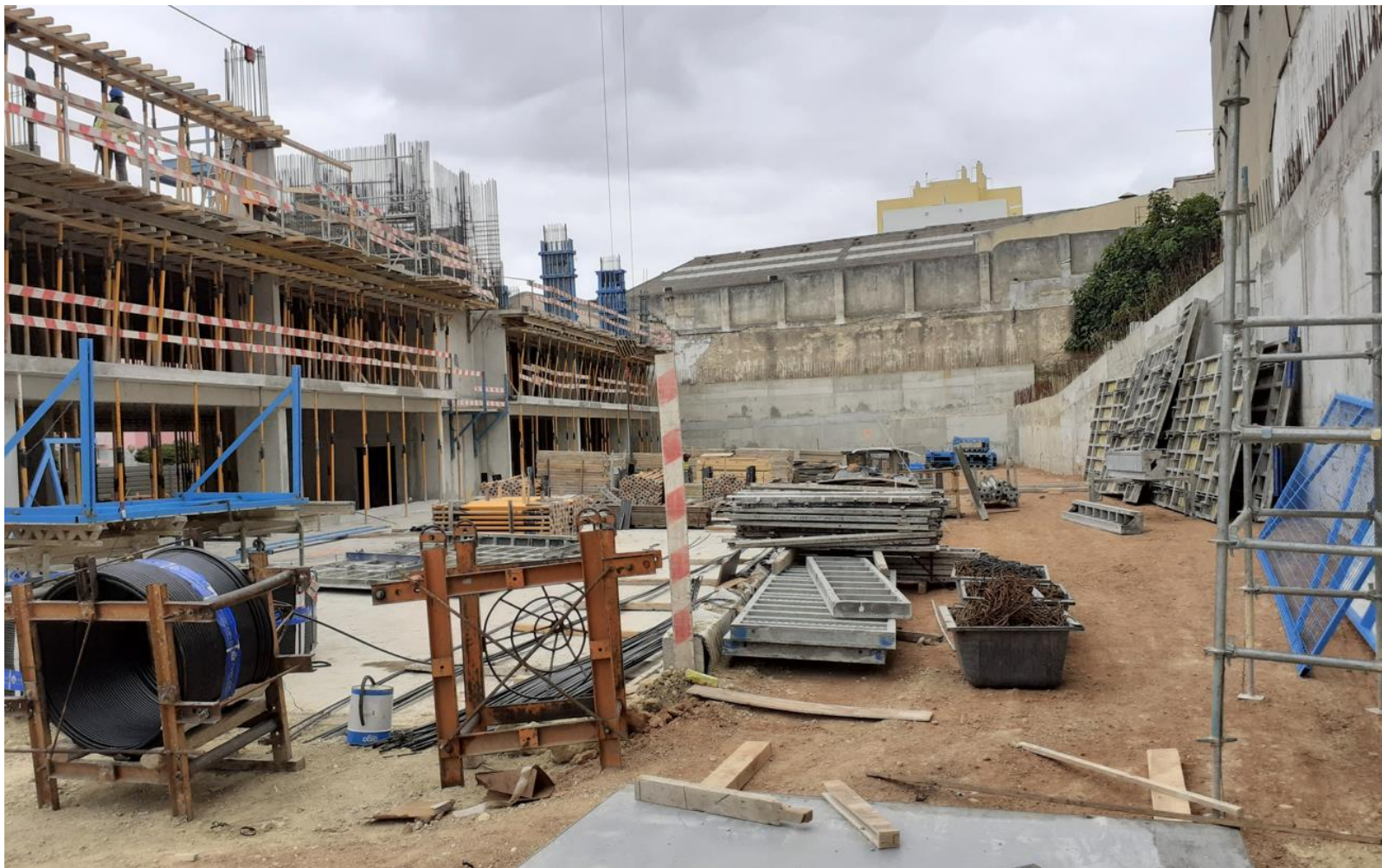
➤ Conclusão do Estacionamento sobre a Parede Norte – Lote 1
