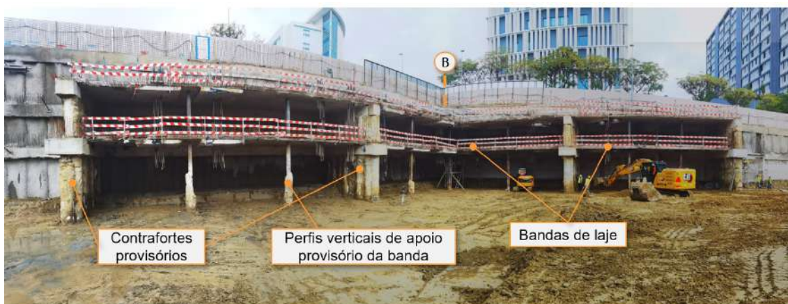
Figura 5 - Alçado fotográfico da estrutura de contenção periférica junto ao canto B.
