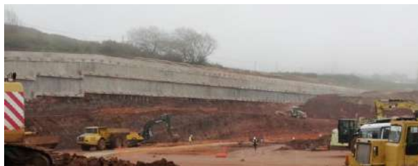
Figura 6 – Vista do andamento dos trabalhos de escavação junto à cortina de estacas.
