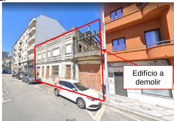
Figura 2 – Vista do local de intervenção antes do início dos trabalhos (imagens retiradas do google maps - street view)
