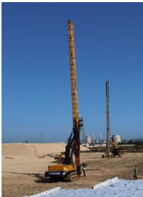
Figura 3 – Execução de drenos verticais pré-fabricados (torre de cravação).
