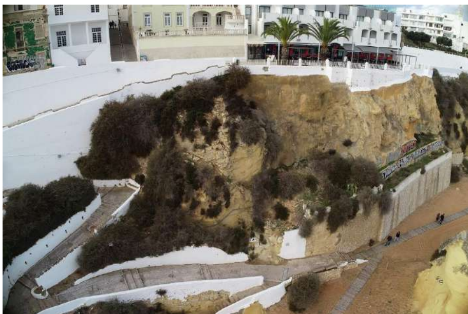
Figura 1 - Vista geral da arriba em estudo antes da intervenção
