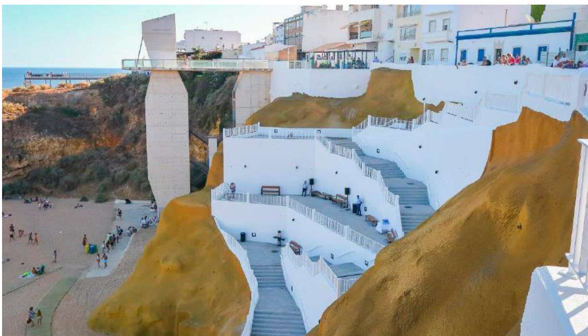
Figura 8 – Vista final da intervenção
