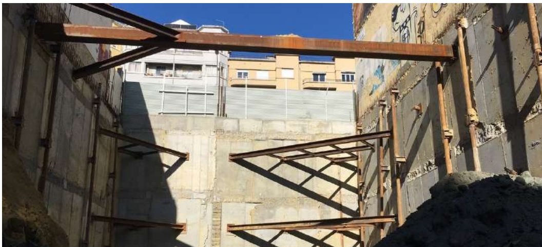
Figura 10 – Vista do alçado Norte (PT à esquerda, Túnel sob Av. João XXI ao centro, edifício existente à direita).
