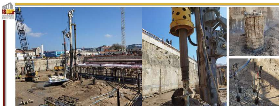
Figura 5 – Trabalhos de execução das estacas de fundação
