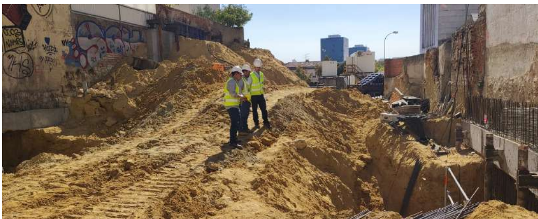
Figura 9 – Início dos trabalhos de escavação junto ao PT / edifício sede CDG
