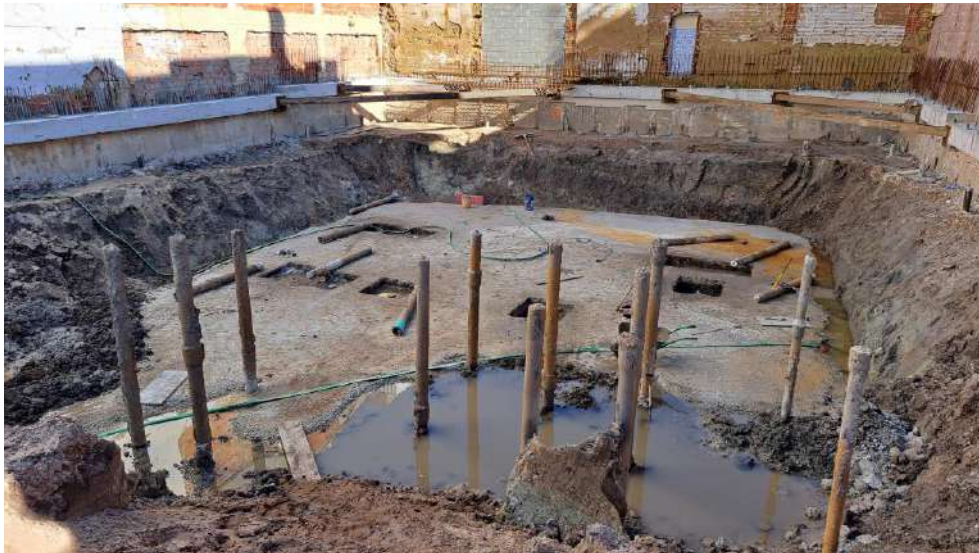
Figura 4 – Vista do local de intervenção antes da instalação das escoras inclinadas
