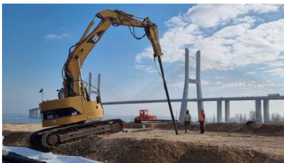
Figura 9 - Cravação das microestacas de ensaio.
