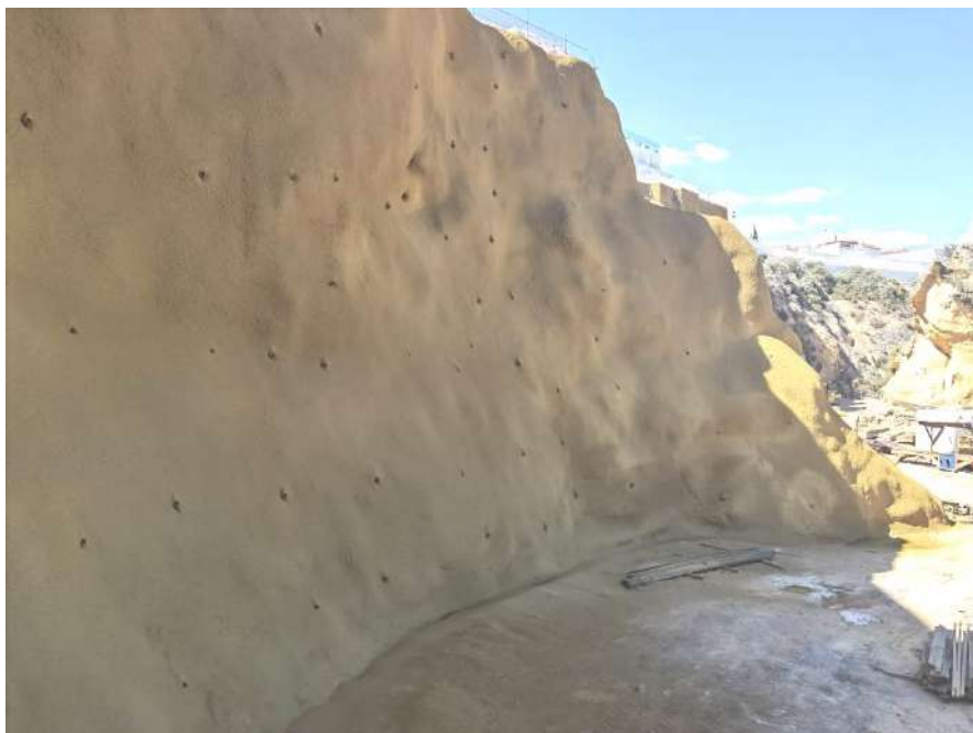
Figura 6 – Aspeto final do revestimento em betão projetado armado e drenado
