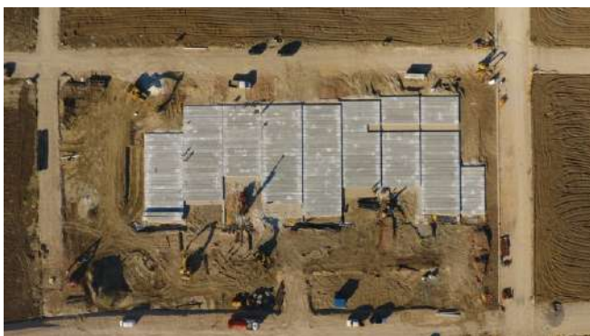
Figura 5 - Fotografia aérea da fundação do palco - zona de fundação direta.
