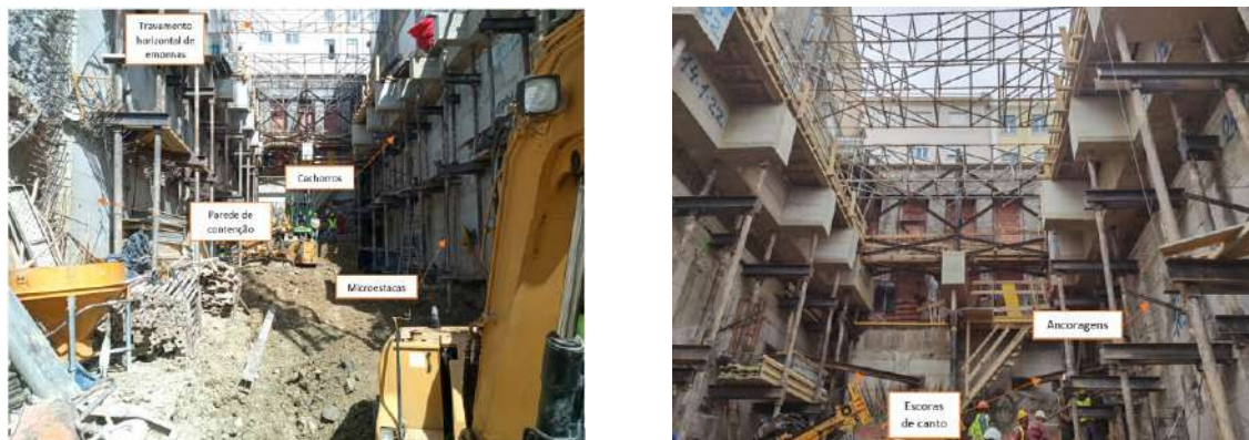
Figura 4 – Fotos capturadas no decorrer dos trabalhos em obra, com identificação de alguns dos elementos mais relevantes
