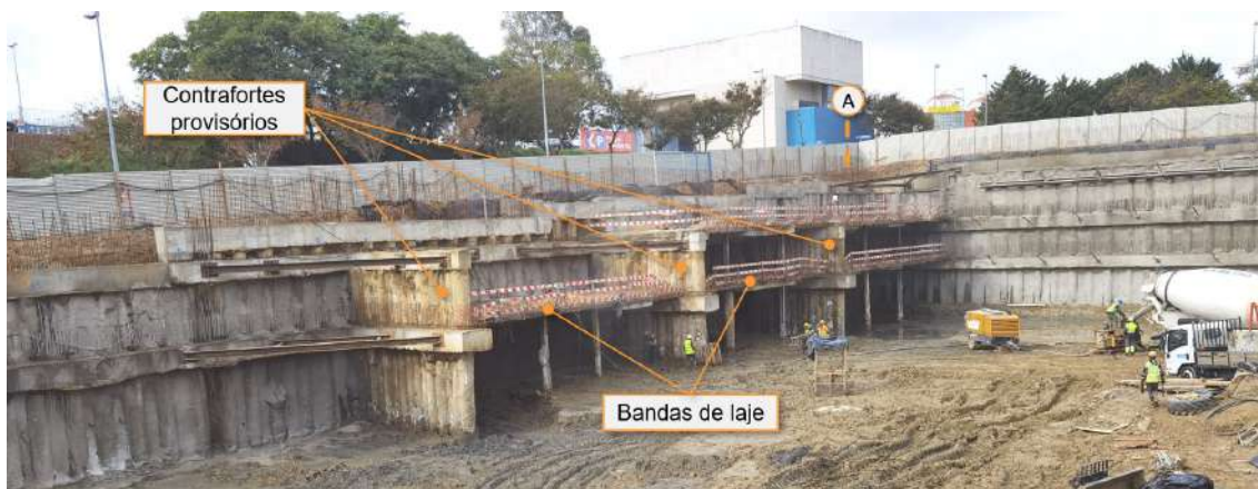
Figura 4 – Alçado fotográfico da estrutura de contenção periférica junto ao canto A.
