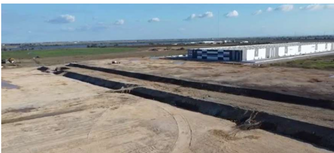
Figura 7 – Fotografia aérea dos aterros de pré-carga
