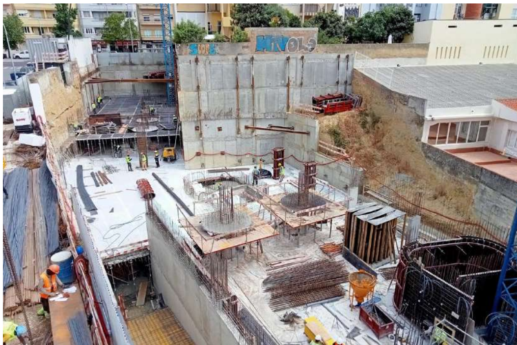
Figura 12 – Vista Global da obra, com início da execução das lajes dos pisos enterrados
