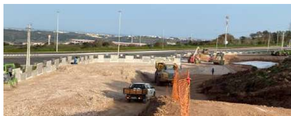
Figura 11 – Vista dos trabalhos de montagem dos muros de terra armada.
