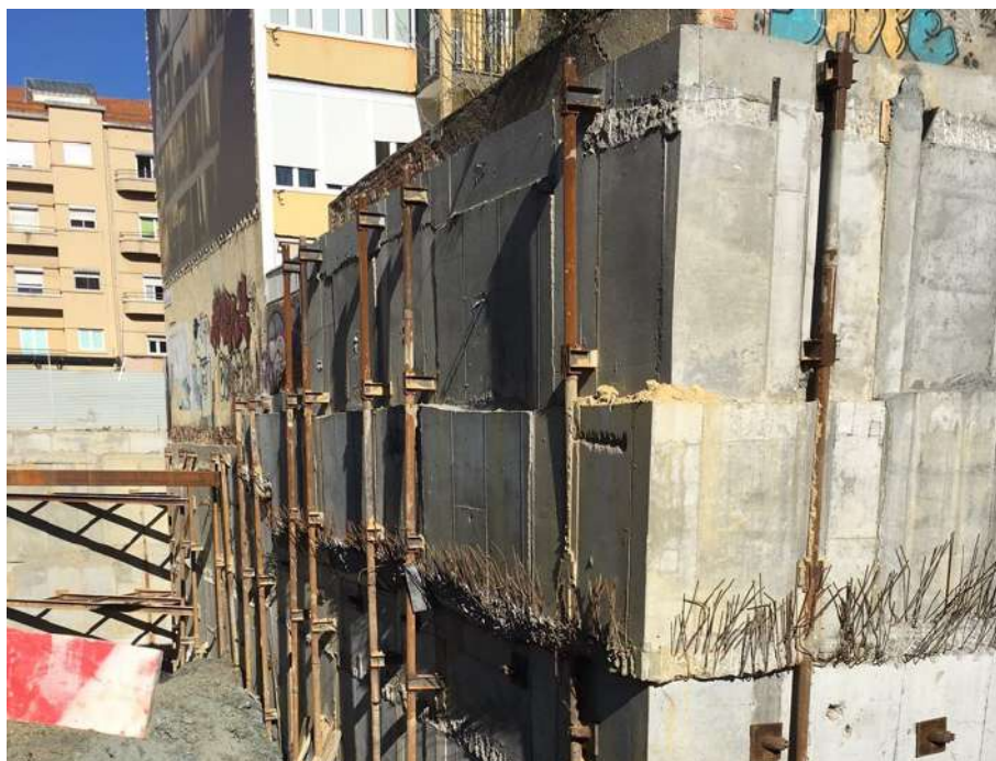
Figura 11 – Zona de Canto da parede – Contenção Periférica a muro existente a tardoz
