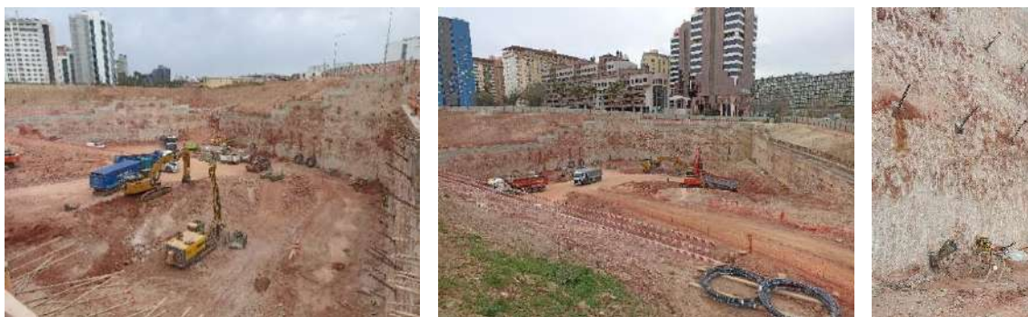
Figura 14 – Vista da obra em fase final dos trabalhos de escavação
