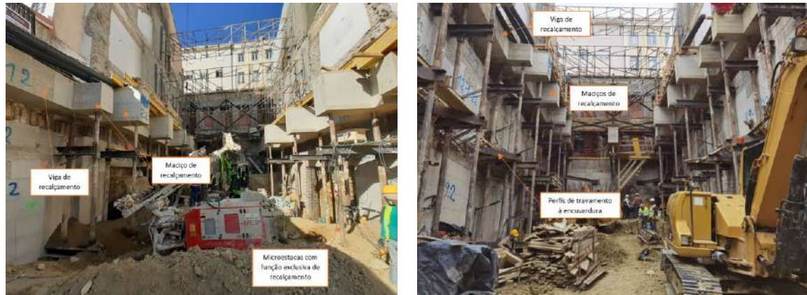
Figura 5 – Fotos capturadas no decorrer dos trabalhos em obra, com identificação de alguns dos elementos mais relevantes
