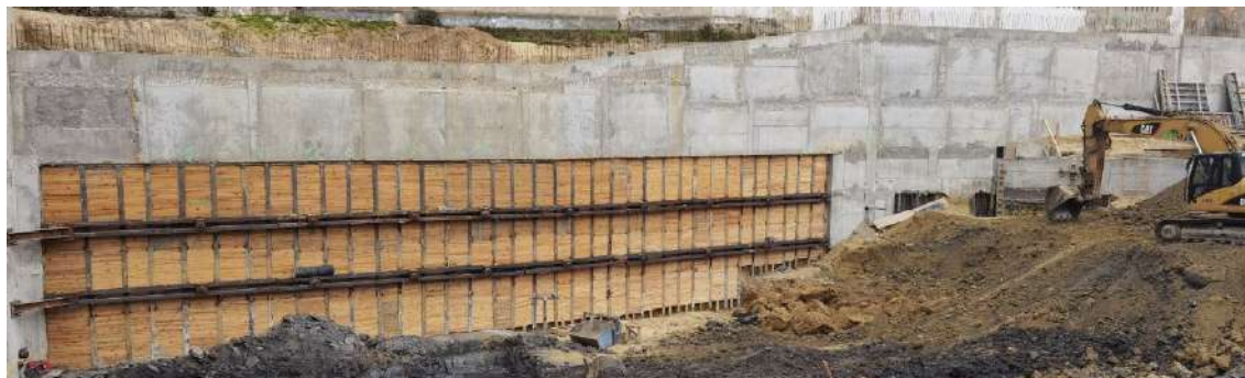
Figura 4 – Vista da execução dos Muros de contenção periférica recorrendo à tecnologia de Berlim Definitivo na parte superior da contenção e Berlim Provisório na parte inferior.
