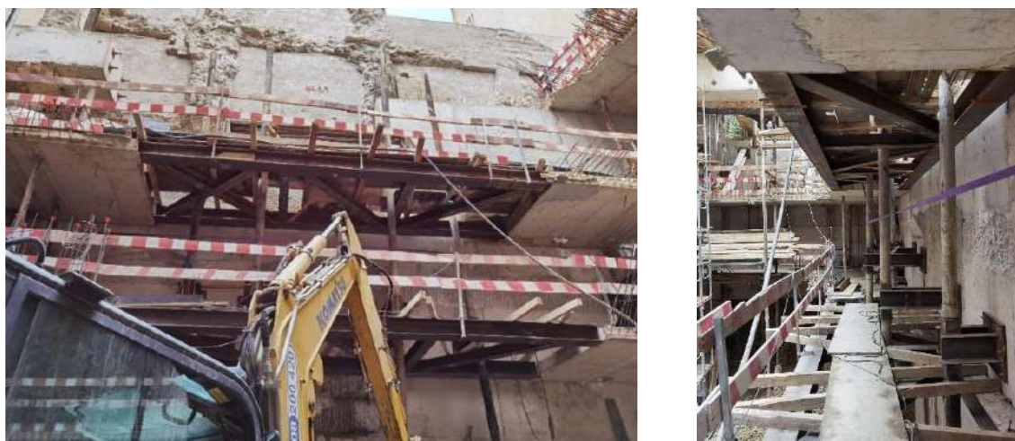
Figura 5 - Solução de Treliça Metálica instalada nas bandas de laje do Piso -1 e -2
