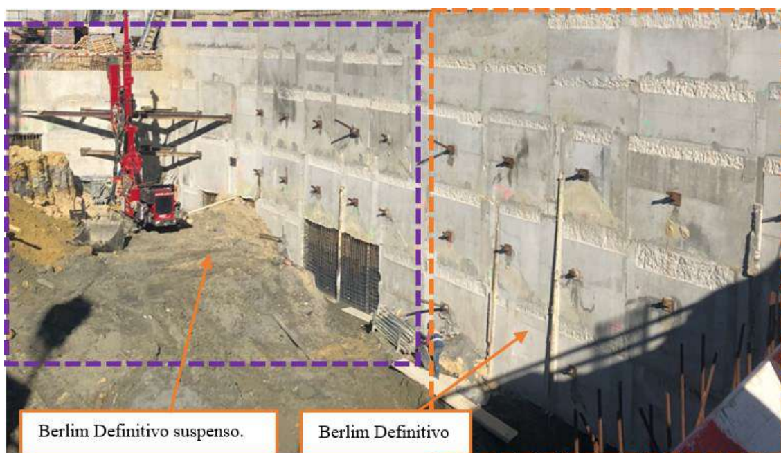
Figura 7 - Execução do Berlim Suspenso.
