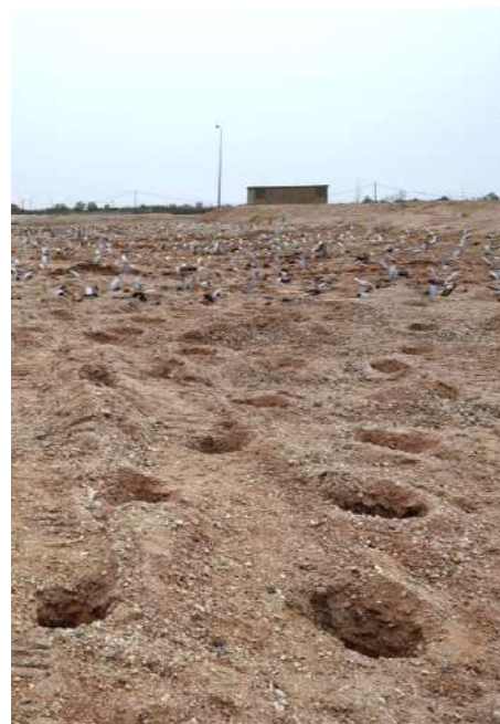
Figura 4 – Execução de drenos verticais pré-fabricados (pré-furos).
