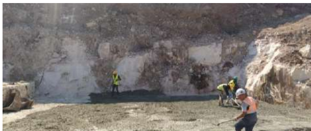
Figura 9 – Vista dos trabalhos de enchimento da base do muro de gabiões com betão ciclópico.
