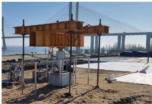
Figura 13 - Estrutura de reação do ensaio de carga à compressão.
