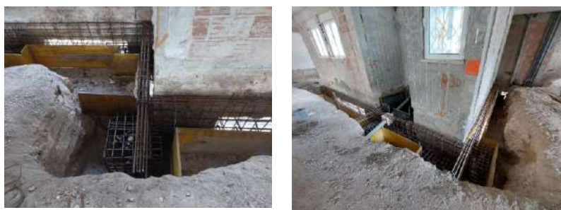
Figura 7 - Colocação da armadura do maciço e das vigas de fundação para execução.
