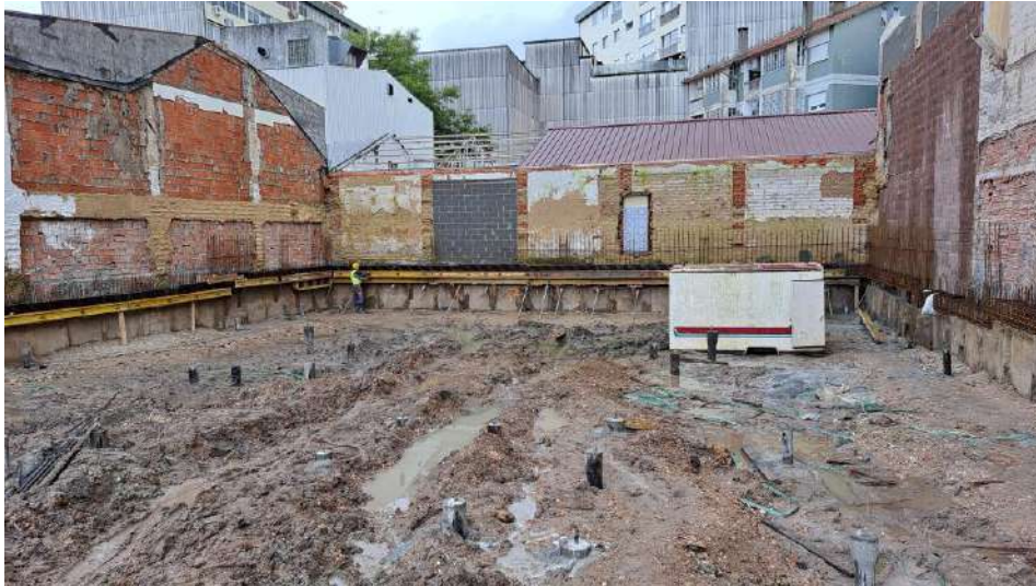
Figura 3 - Vista do local de intervenção após demolição, execução das microestacas dúcteis cravadas.
