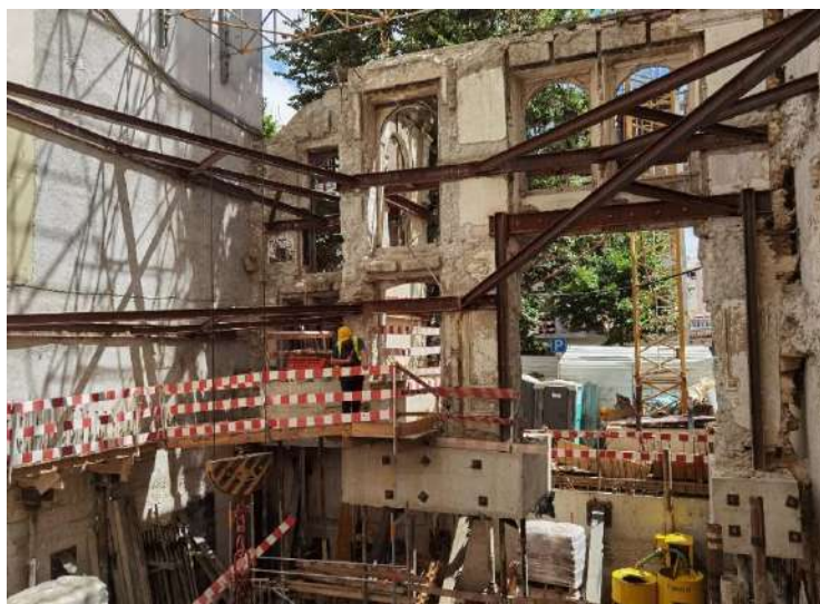
Figura 3 - Solução de Contenção e Recalçamento de Fachada em fase obra- Alçado Principal
