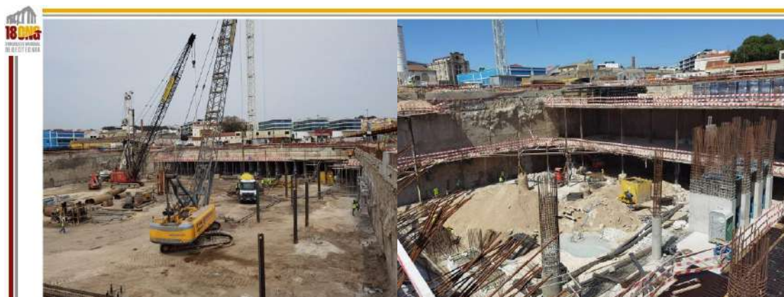
Figura 7 – Trabalhos de escavação e de execução do travamento das paredes de contenção
