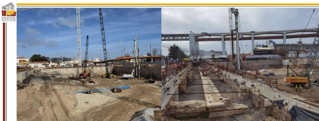
Figura 6 – Trabalhos de escavação e de execução do travamento das paredes de contenção
