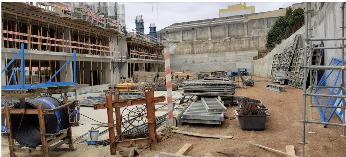
Figura 7 – Vista do aterro na zona da contenção do Lote 1 do tipo Berlim Misto finalizado até à cota do piso 0
