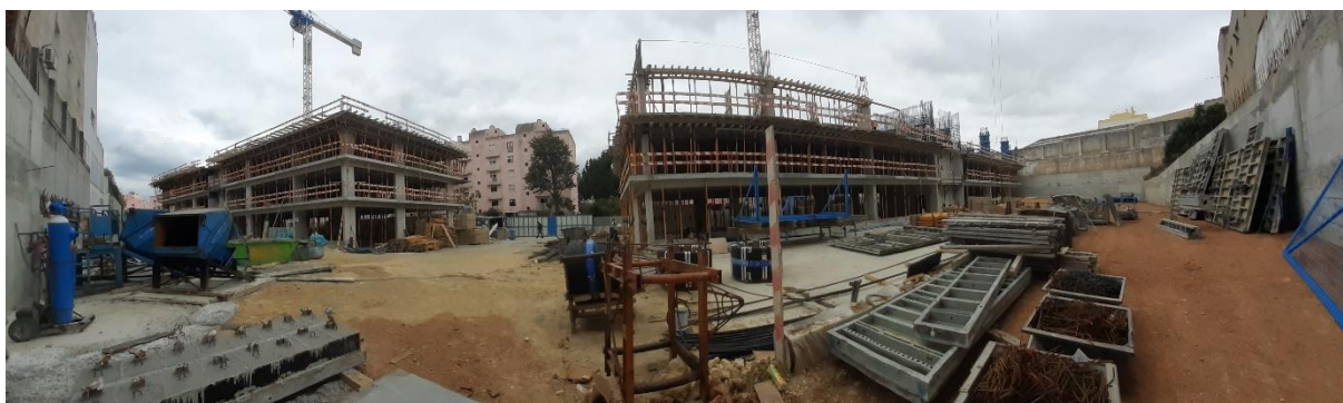
Figura 10 – Vista da construção da superestrutura do lote 1(lado direito) e do lote 2 (lado esquerdo)
