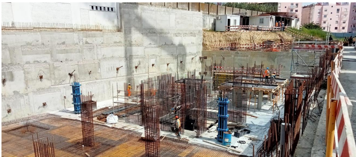
Figura 9 – Vista da betonagem da laje do piso -2 do lote 2
