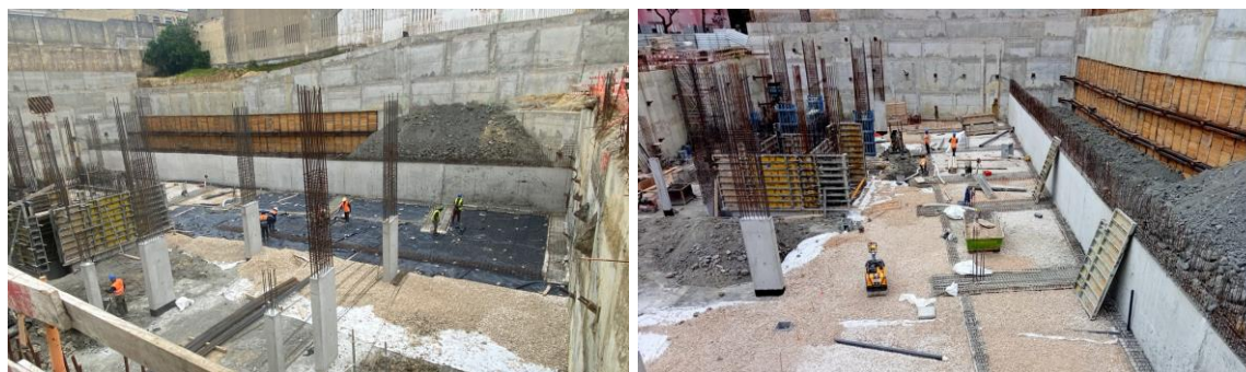
Figura 6 – Vista do início do aterro entre parede do lote 1 e a parede de contenção periférica
