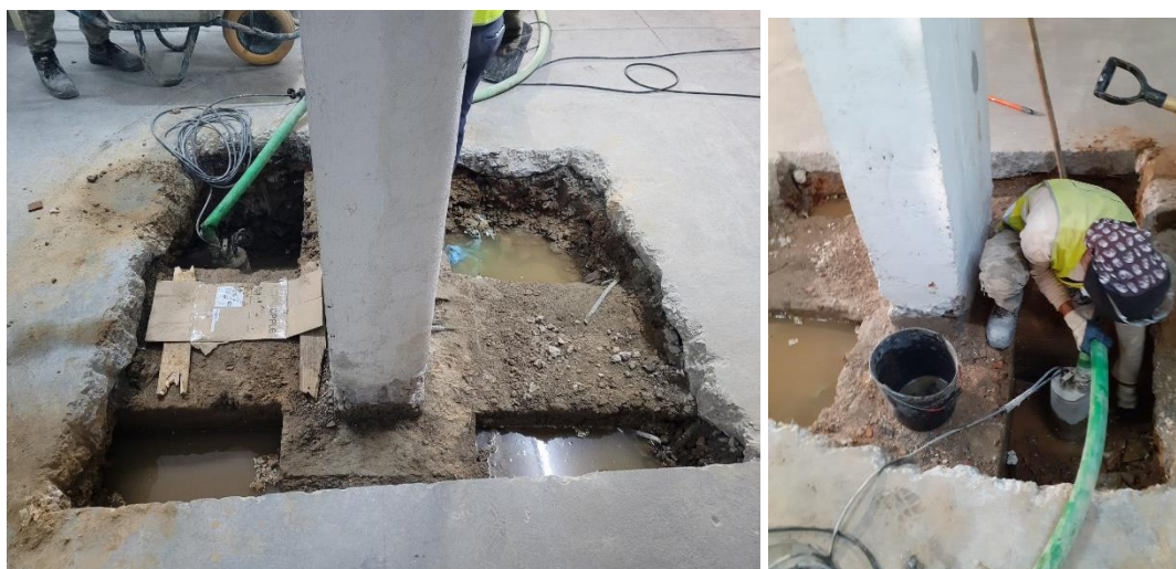
Figura 7 – Vista dos poços de inspeção das fundações existentes.
