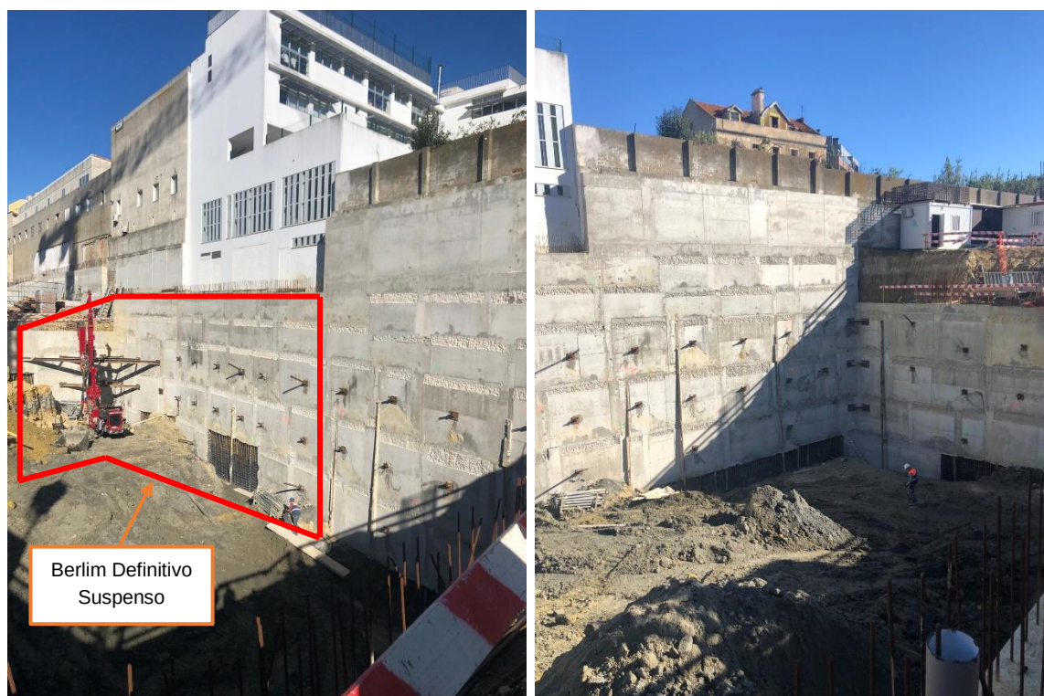
Figura 8 – Vista dos trabalhos junto ao fundo de escavação – Lote 2
