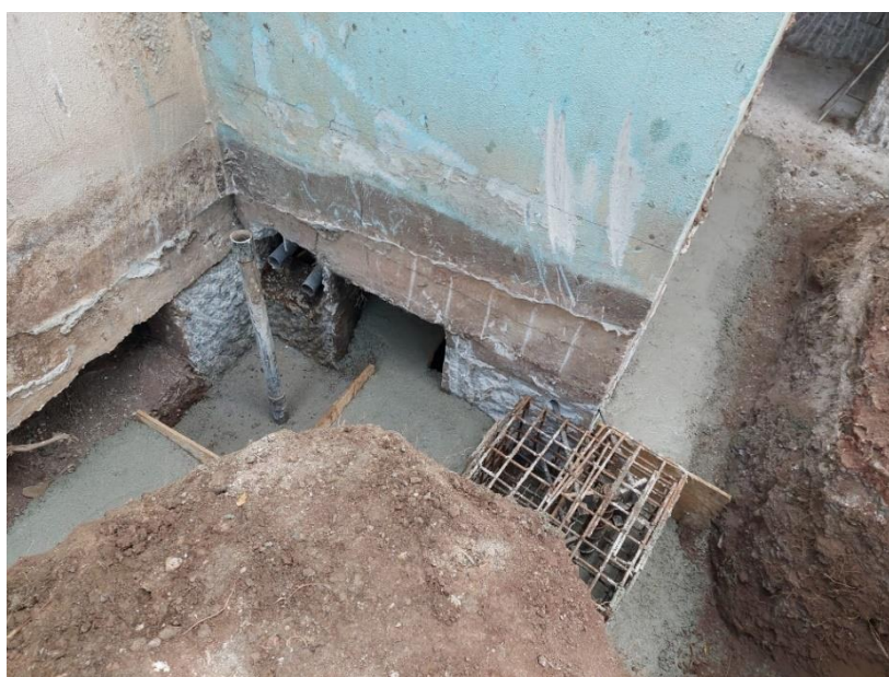
Figura 8 - Pormenor da picagem dos pilares e das vigas de fundação existentes.
