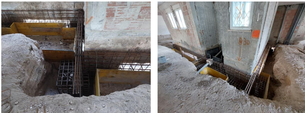
Figura 9 - Colocação da armadura do maciço e das vigas de fundação para execução.
