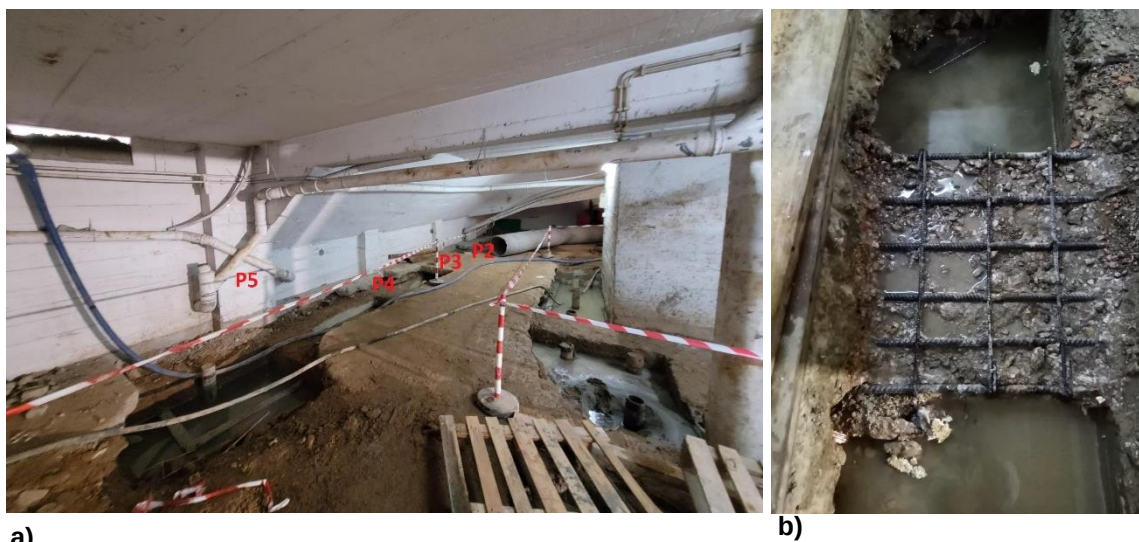
Figura 8 – a) Vista da semicave durante a intervenção b) Vista da picagem de viga de fundação.
