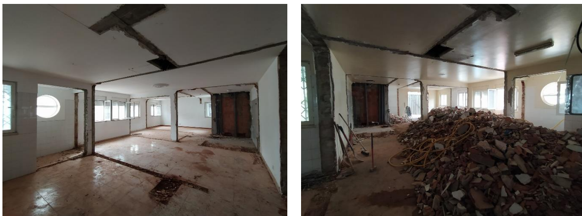
Figura 10 - Remoção do interior do R/C do edifício e manutenção das fachadas.
