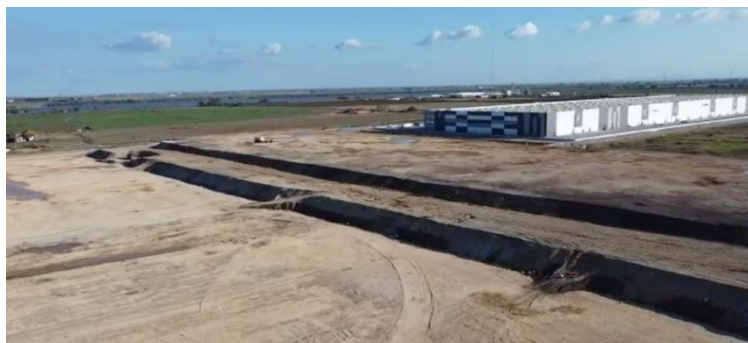
Figura 7. Fotografia aérea dos aterros de pré-carga.
