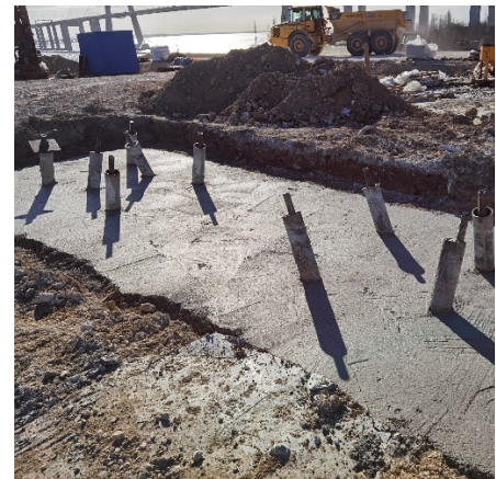
Figura 4 – Microestacas de fundação da cobertura do palco.
