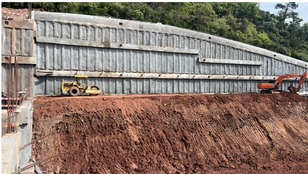
Figura 8. Vista da fase final de execução do aterro implementado como primeira medida de reforço.
