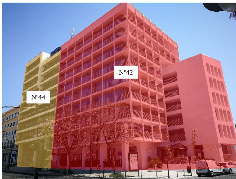
Figura 1. Edifícios de betão armado situados por cima do túnel.
