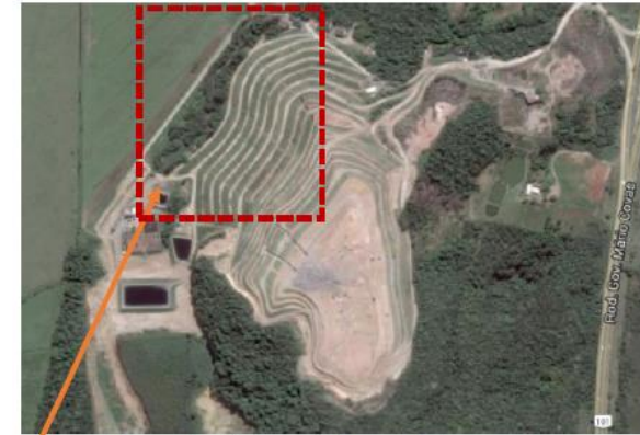
Figura 1 – Vista geral da zona da intervenção
