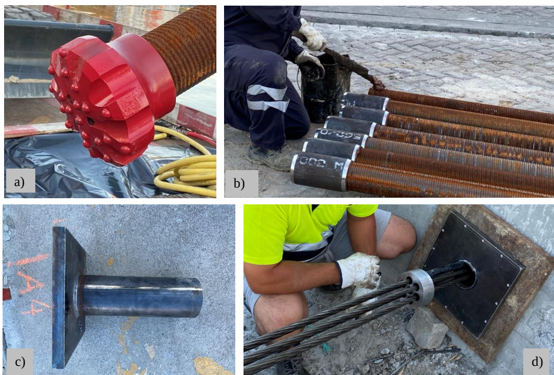
Figura 5. a) Bit perdido com botões balísticos de tungstênio; b) Preparação das uniões entre troços de barra oca autoperfurante; c) trompa de ligação da barra autoperfurante à ancoragem de cordões; d) Placa de apoio de cunhas da ancoragem de cordões.
