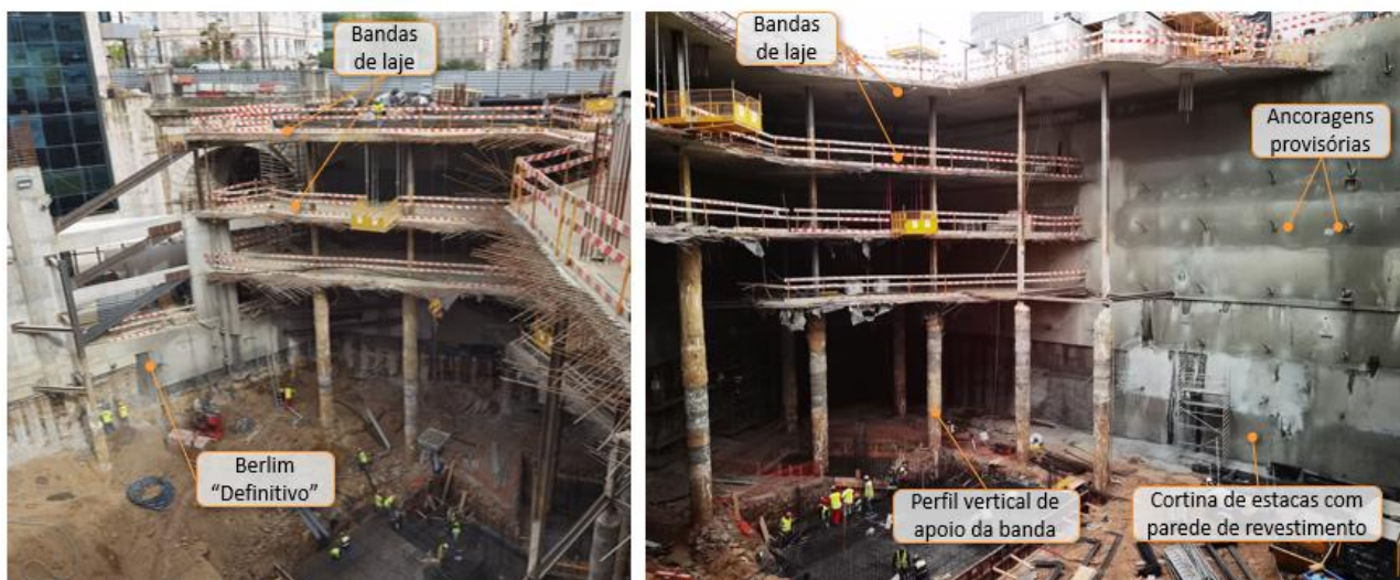
Figura 4. Fotografias da estrutura de contenção periférica – virada para a Av. Fontes Pereira de Melo (à esquerda) e virado para a Av. António Augusto Aguiar (à direita)
