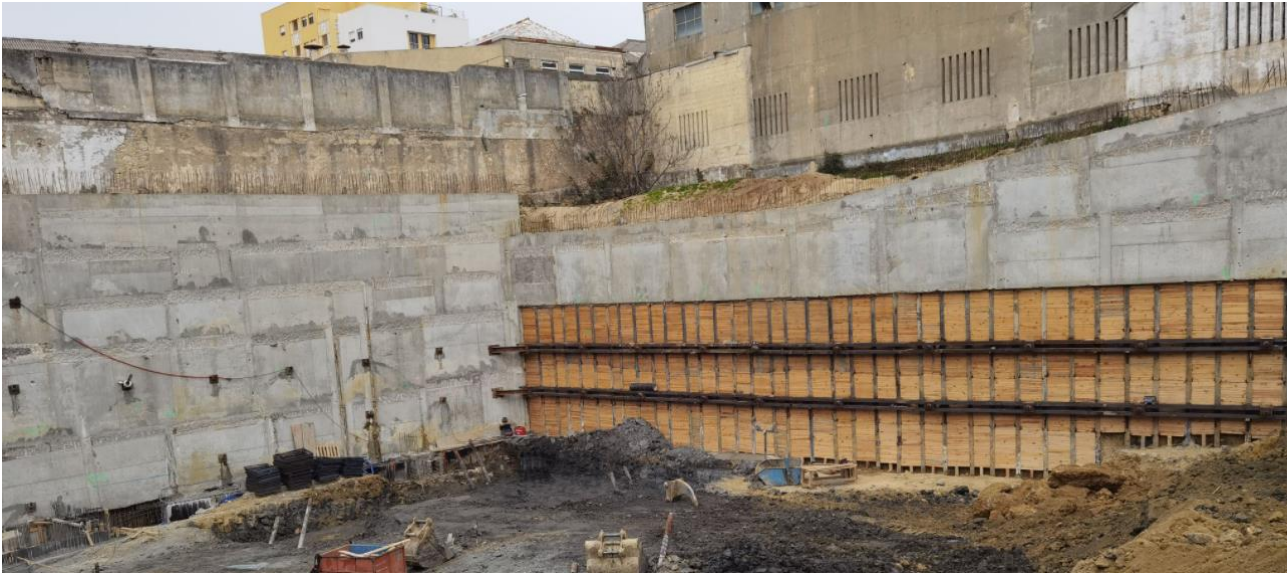
Figura 4. Contenção periférica do tipo Berlim Misto (definitivo em cima e provisório em baixo) no Lote 1.
