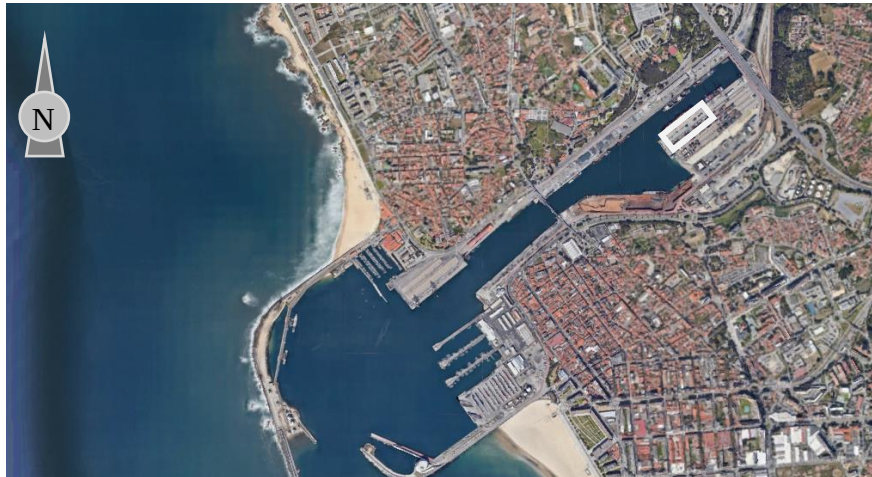
Figura 1. Localização da Doca Sul n.º4 do Porto de Leixões em Matosinhos, Portugal [fonte: Google Earth].
